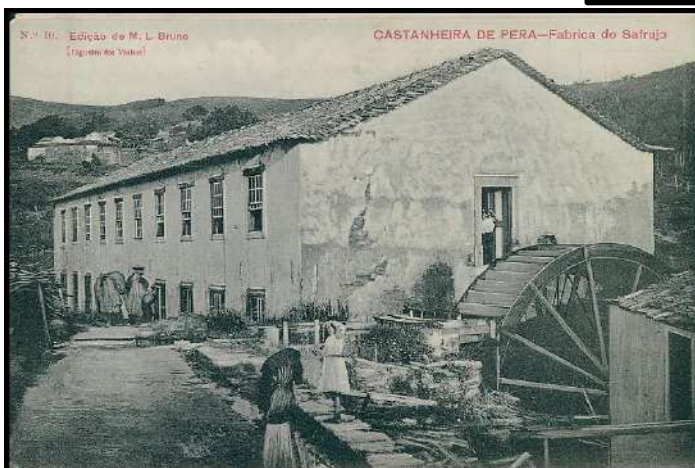
Figura 5. Fábrica do Safrujo . Pormenor da roda hidráulica. Dimensões estimadas: 8 metros de diâmetro e 2,5 metros de largura.
